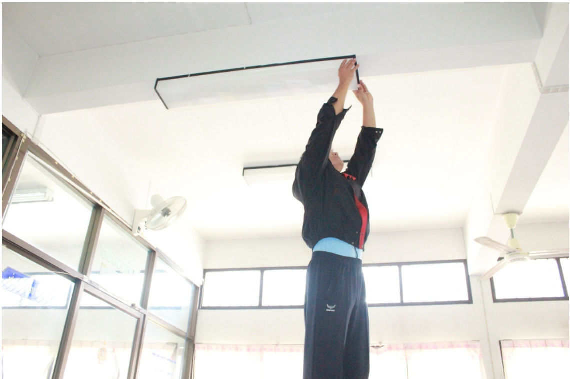
ภาพการเปลี่ยนคอมไฟ สายไฟ ที่ชำรุด เพื่อให้มีสภาพดี ปลอดภัย พร้อมใช้งาน
